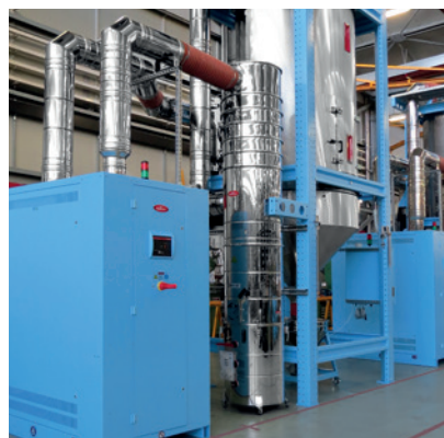
MPK installation. Installazione MPK.
