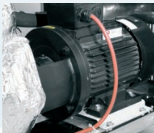
Pump with athermic joint. Pompa con giunto atermico.
